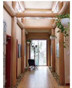
写真 スギ磨き丸太を用いた「耐力壁置換フレーム」
