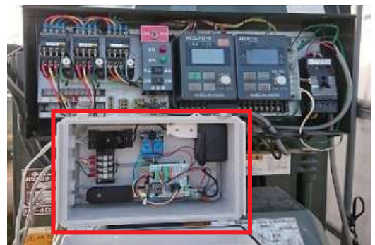
写真 日没後自動加温制御機器（赤枠内） (既存加温機の外部入力接点に接続する)
