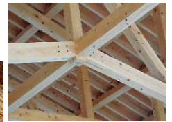
写真 梁・桁材
