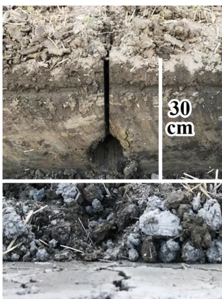
第1図 明渠から弾丸暗渠の施工の断面の様子
