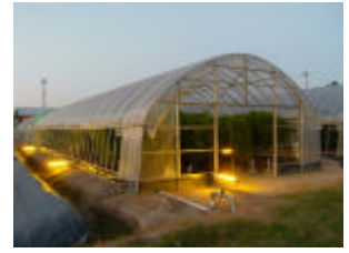
黄色蛍光灯ハウス外側設置の様子
