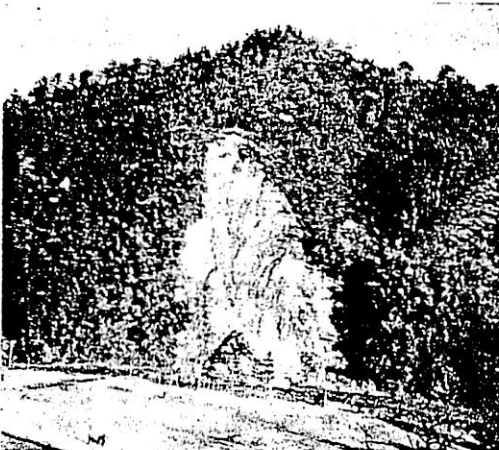
(3) 山脚末端に生じた崩壊。大小の亀裂を伴い。斜面の基部は溪流により喪失している。 (1b)~(2b) (花崩閃緑岩)
