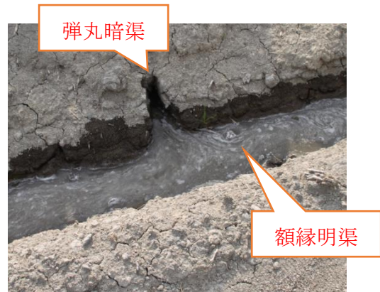
図2 額縁明渠から弾丸暗渠に入水する様子
