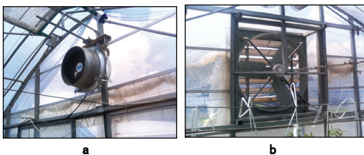
第1図 本試験に用いた外気導入ファン(a)と換気扇(b)の設置状況
